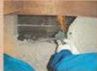
3. 鉄筋の切断
