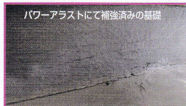
犬走りと基礎に隙間が出来るほど動いているが、基礎自体には損傷が無い。
