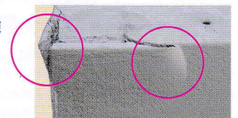
この事は被災時に家屋が瞬時に倒壊してしまう事態をパワーアラストを塗布することで、効果的に抑制できると判断されます。
